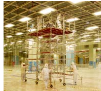
現場施工實例
